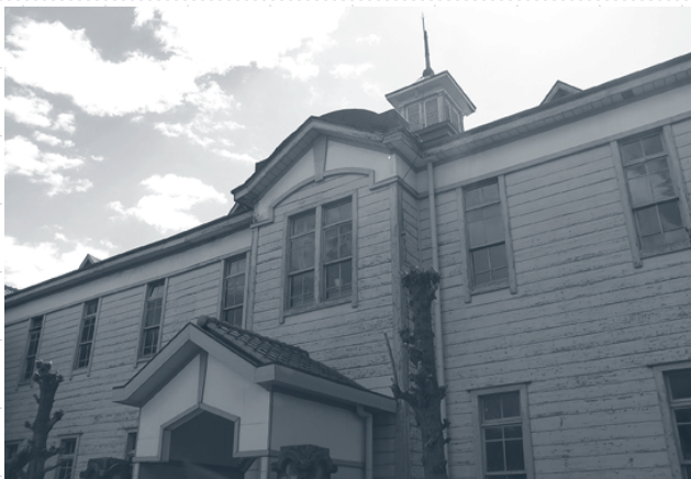
深谷商業高校の校舎の一部は、大正時代の建築技術の粋を集めて建てられた木造校舎で現存する唯一のもので、現在は、授業等では使用しておらず、記念館になっている。
